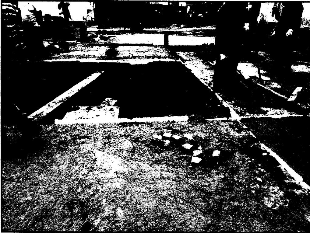
*Fig. 03 vaciado de concreto  $f_c= 280 \text{ kg/cm}^2$  para patio de maniobras.*
